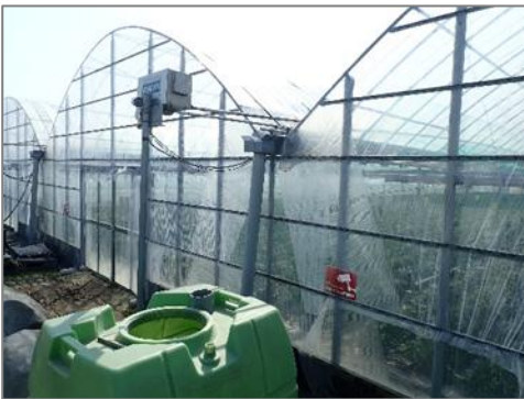
防犯カメラの設置
